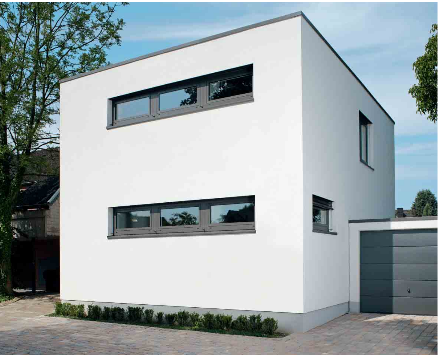
Fenster sind dominante Gestaltungselemente.
